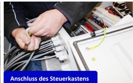
Anschluss des Steuerkastens
